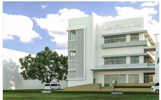
อาคาร ICU แผนเสร็จในปี 2563
